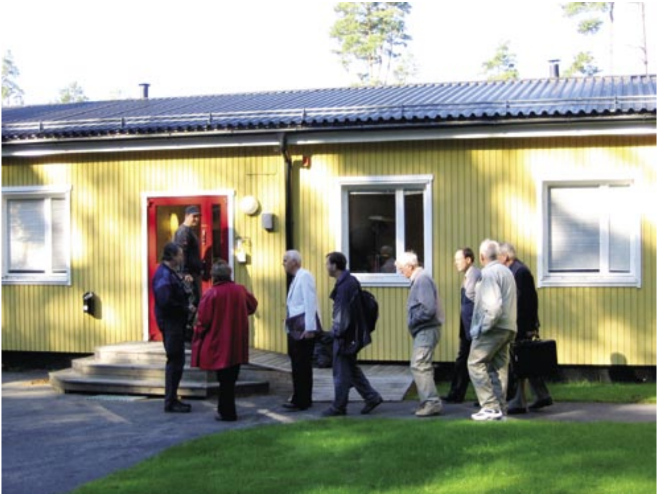
Gula baracken är kvar med kontor, bastu och motionsrum
