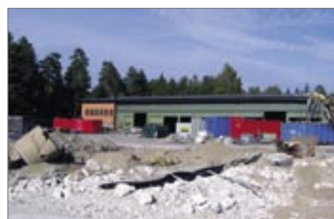
Flygverkstaden under rivning
