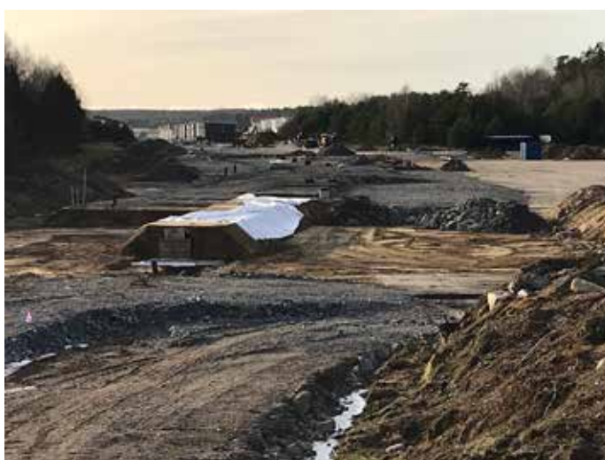
Markarbeten vid Hanvedens allé
